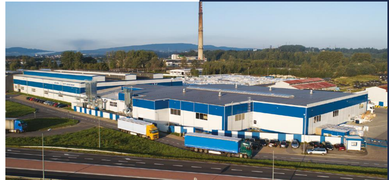
Výrobní závod sendvičových panelů, Gorlice
